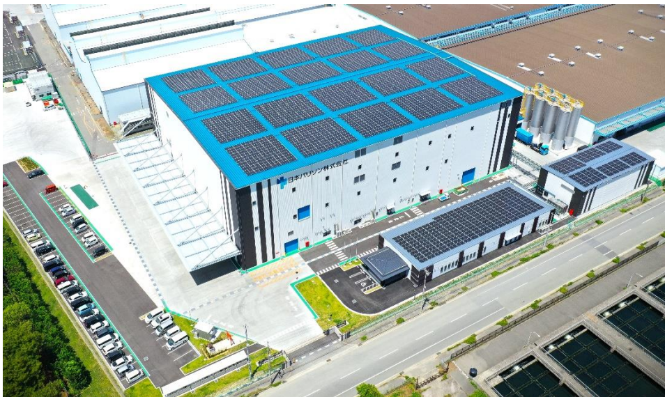
日本パリソン株式会社・姫路工場に設置した太陽光発電システム
